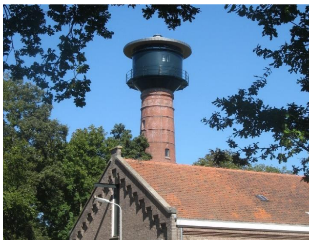
De gerestaureerde en gerenoveerde watertoren is nu een éénkamerhotel.
