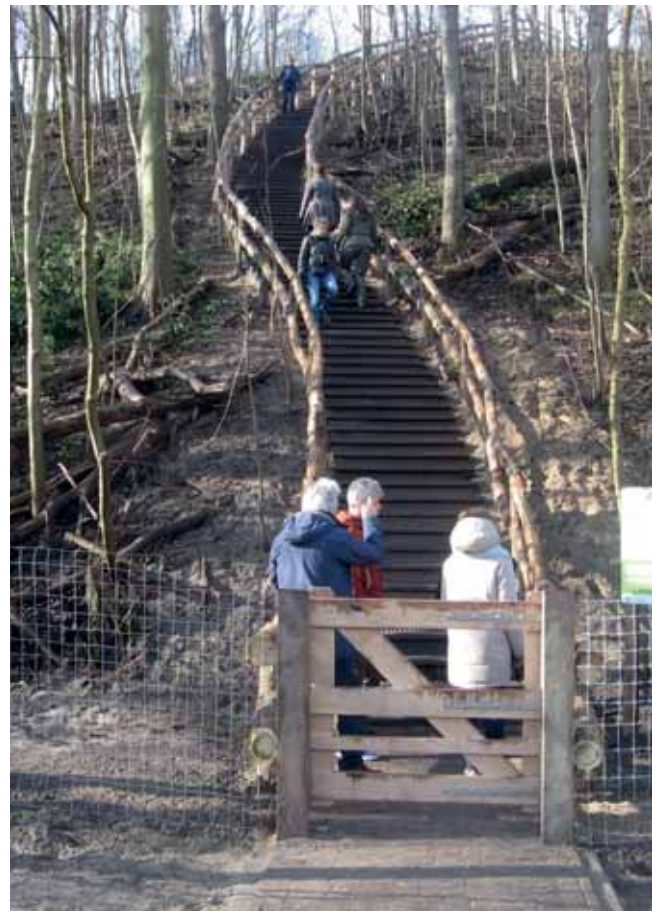
De trap ligt er, nu het uitzichtplatform nog!
