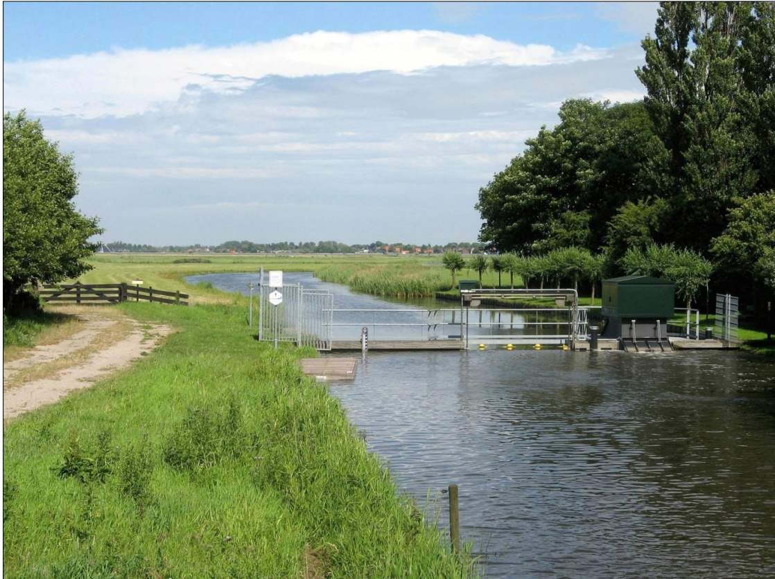
Stuw en gemaal bij de Hoge Brug.
